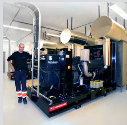
Montasje av strømaggregat hos kundar
