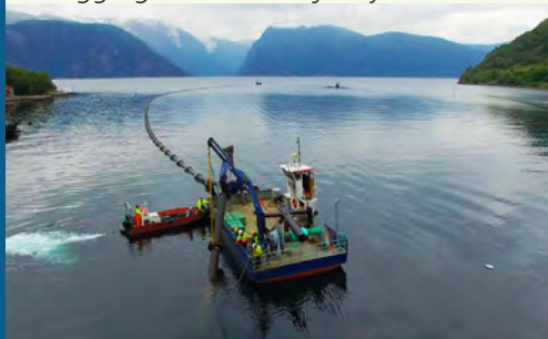
Pumperom Utlegging av inntaksrøyr i sjø
